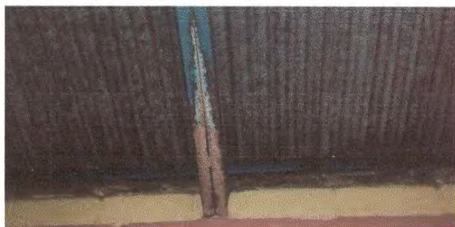
Foto 3: Estructura de techo.
