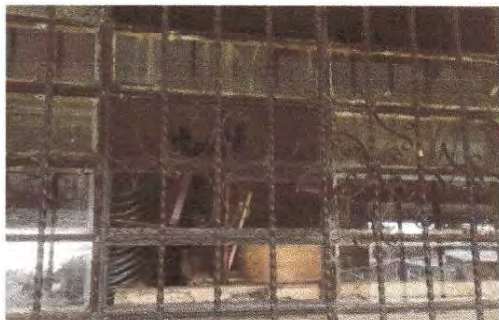
Foto 7 : sustitucion de estructura de metal a ventana
