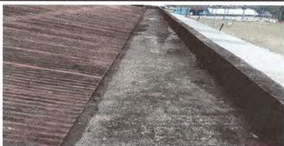
Foto 5: Impermeabilización de losa.
