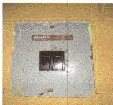
Foto 10: Sustitucion de tablero de flipones
