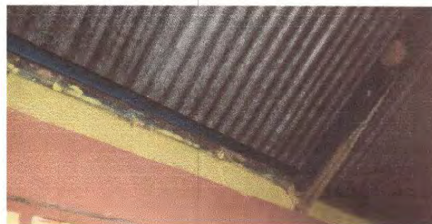
Foto 4: Mantenimiento a estructura de soporte de metal.
