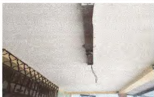
Foto 9: Sustitucion de lamparas tipo LED
