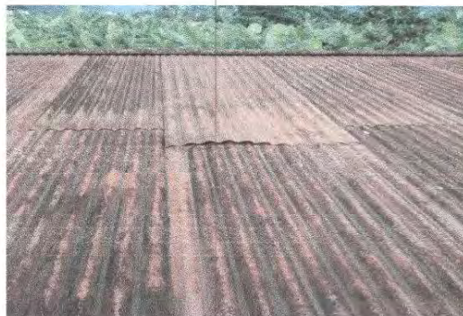
Foto 2: Sustrucion de lamina por lamina calibre 26. Edificio completo. (baños, cuatro aulas y direccion)
